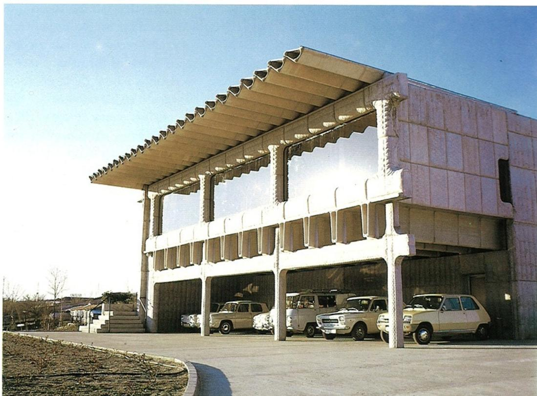
Estudio en Cerro del Aire. Madrid (1971). Este edificio, por tratarse de mi propio local de trabajo, me ha servido como ocasión de ensayo de algunas soluciones de postesados, de encofrados flexibles realizados *in situ*, de eliminación de carpintería y su sustitución con simples juntas de neopreno, de separación de ventilación e iluminación, etc. En general, estas soluciones se han repetido en construcciones posteriores.
