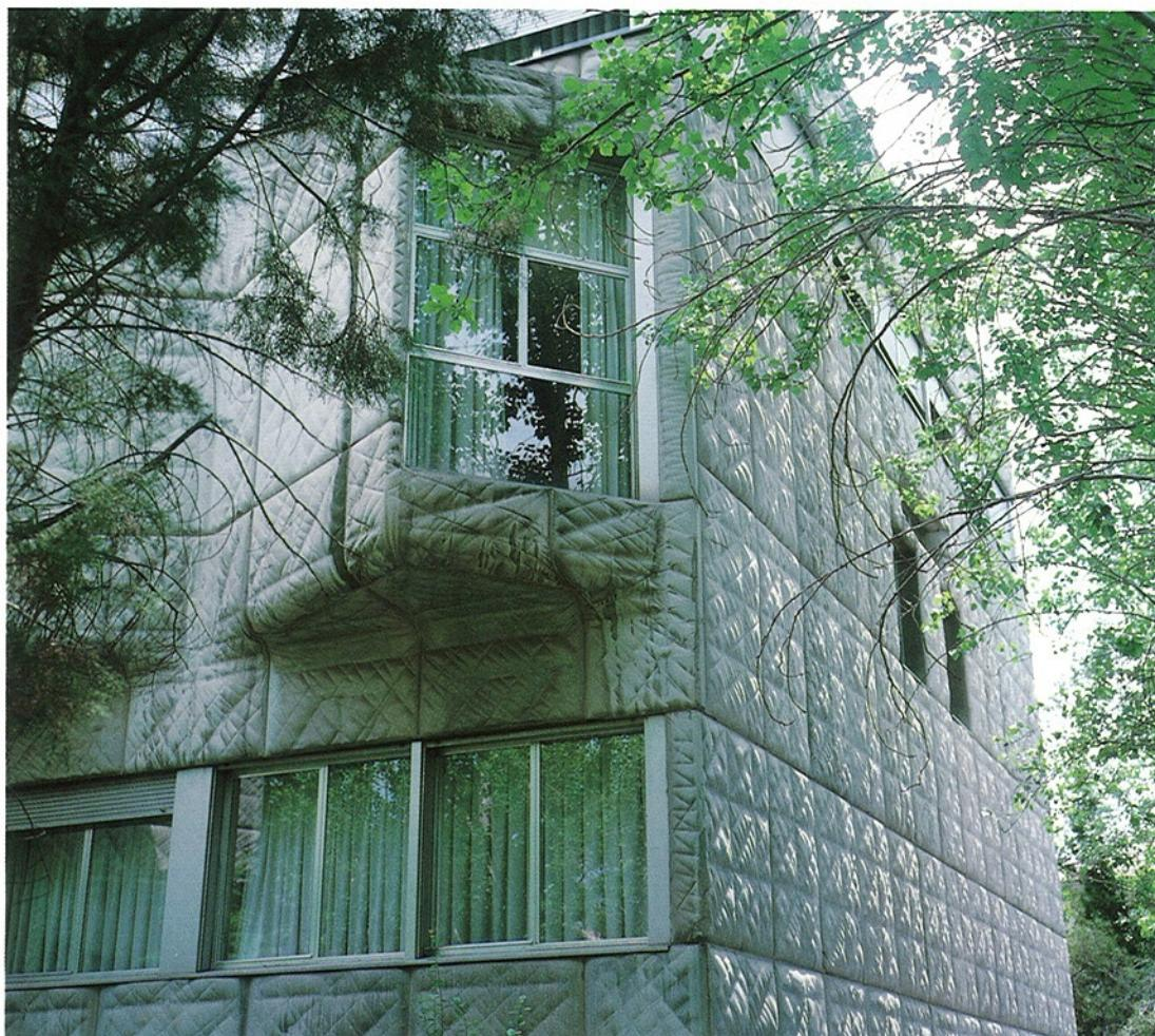
Centro de Rehabilitación para la Mutua del Papel, Prensa y Artes Gráficas. Madrid. (1971). En este edificio con paramentos de fachada de piezas de hormigón armado, ensayé por primera vez encofrados flexibles que he seguido utilizando en otros edificios con muy buenos resultados tanto de conservación como de textura y color.
