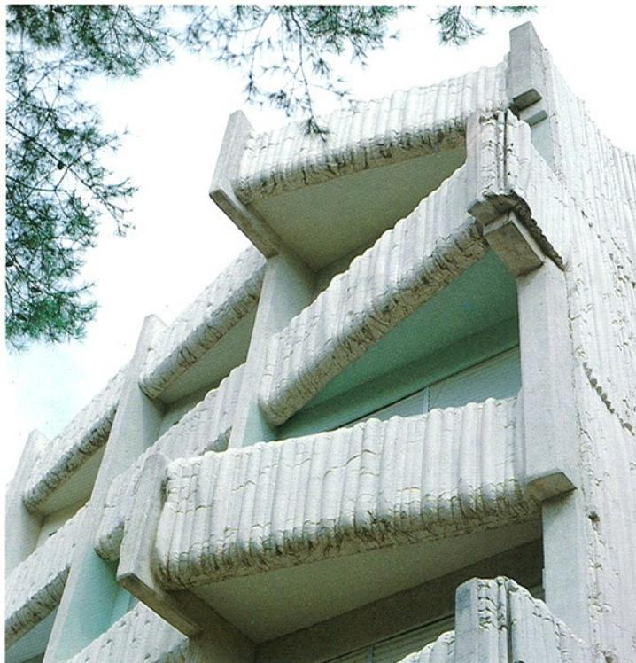
Edificio de Viviendas. Daimiel (Ciudad Real) (1978). *Solución de fachada con paneles de hormigón realizados con encofrado flexible y estructura vista de hormigón armado, todo ello en su color.*
