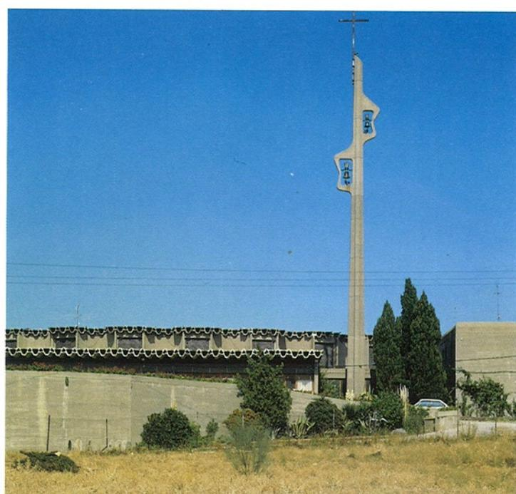
Colegio de la Asunción. Madrid (1965). *La adaptación de todo el conjunto a un terreno bastante movido, las imposiciones pedagógicas y la solución prefabricada de hormigón, con cubierta de piezas huecas pretensadas, prevista para realizar las obras con rapidez (a los 6 meses de comenzar las obras se ocupó el edificio) fueron las premisas que condicionaron el resultado final.*
